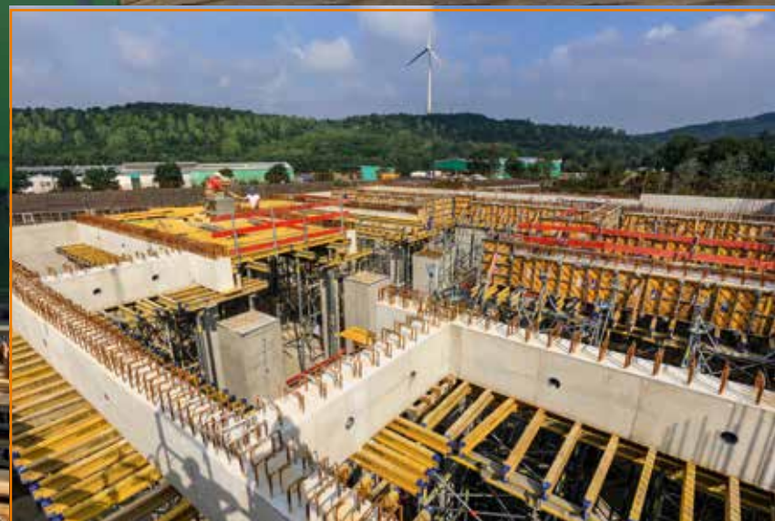
Blick auf die 12 Meter Ebene der neuen Energiezentrale – noch ohne Decke.
