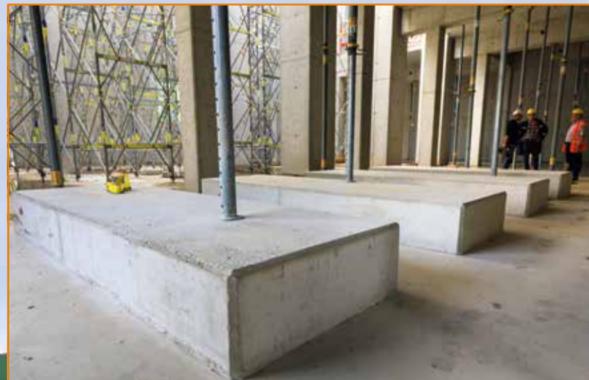
Mitte August waren auch die Fundamente für die vier Fernwärmepumpen fertig.
