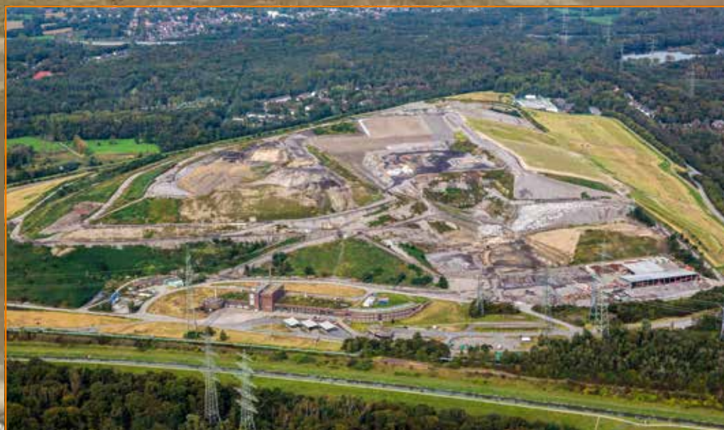
Die Zentraldeponie Emscherbruch – hier ein luftiger Blick von Süden aus – ist seit 1968 in Betrieb. Abfälle der Deponieklassen I, II und III werden hier sicher entsorgt.
