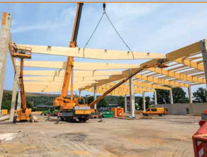
Anfang Juli stand bereits das Grundgerüst der neuen Halle.
