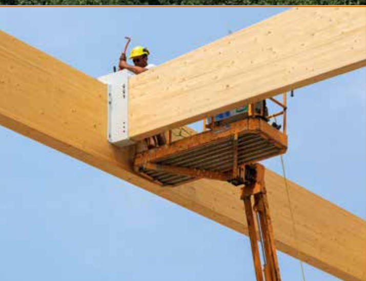
Der Bautruppi fixiert hier gerade einen der vielen Trägerbalken für das Dach.
