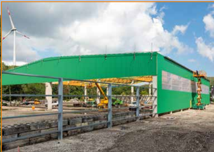
Im August folgte die Montage der Hallenwände – auf dem Bild sind die Sichtschutzwände zur Straßenfront noch nicht befestigt.
