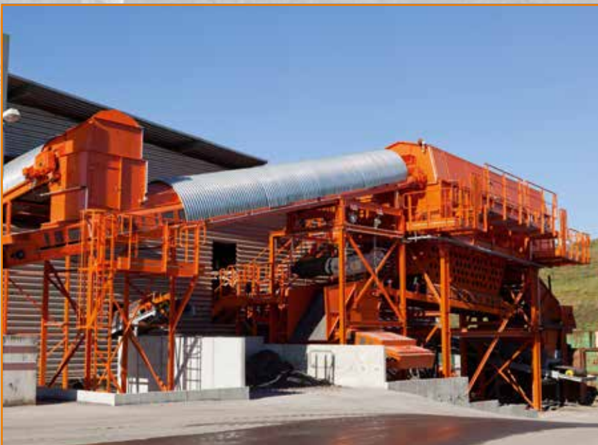
Blick auf die Schlackeaufbereitungsanlage am Standort der Zentraldeponie Emscherbruch.
