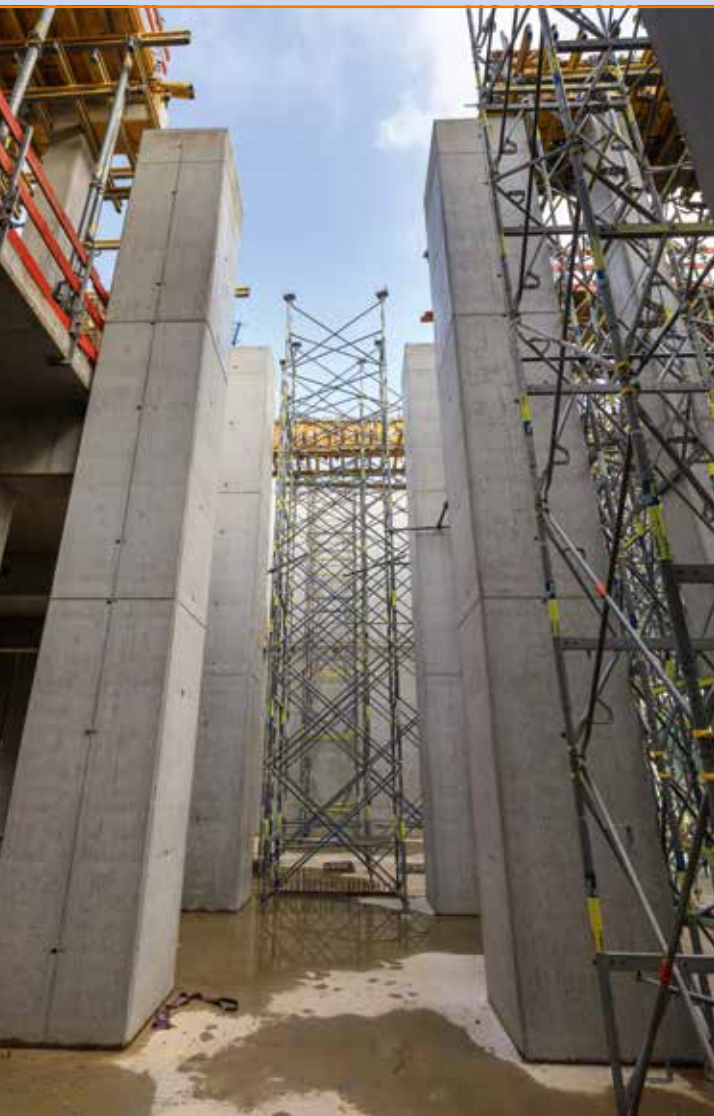
Die Energiezentrale 3 zeigt erste Konturen. Hier zu sehen vier der sechs Stützen für den massiven Tisch, auf dem die 25 Tonnen schwere Turbine in zwölf Metern Höhe ruhen wird.
