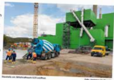
Baustelle am Abfallkraftwerk RZR Herten.
