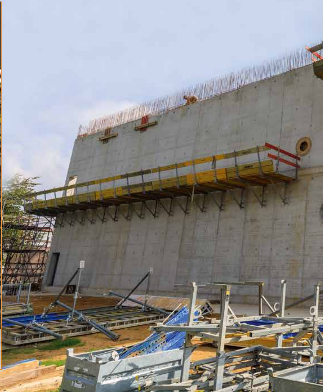
Die Energiezentrale 3 zeigt erste Konturen. Hier zu sehen vier der sechs Stützen für den massiven Tisch, auf dem die 25 Tonnen schwere Turbine in zwölf Metern Höhe ruhen wird.
