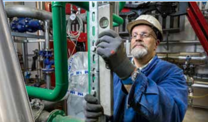
Alles senkrecht? Mit der Wasserwaage wird der Sitz der Verstrebungen überprüft. Genauigkeit ist oberstes Gebot.
