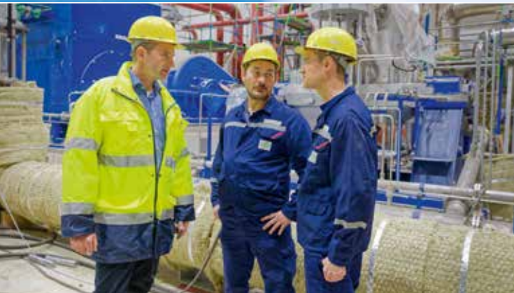
Lagebesprechung in der neuen Energiezentrale III: Stefan Semer (links) erläutert seinen Mitarbeitern, was in den nächsten Tagen ganz besonders gefordert ist.
