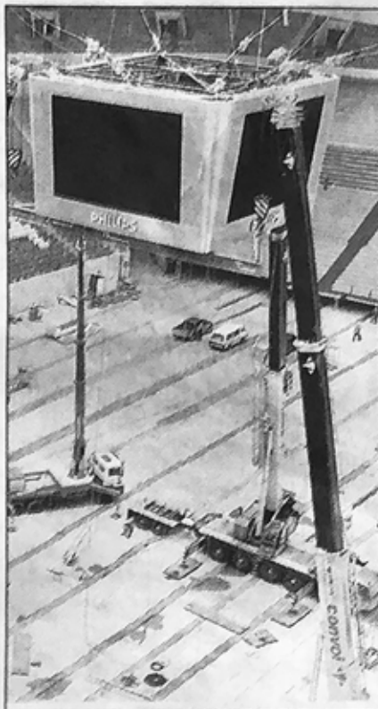
Kraftakt: mit Kränen wurde der Koloss (29 Tonnen) an die Decke gehoben
