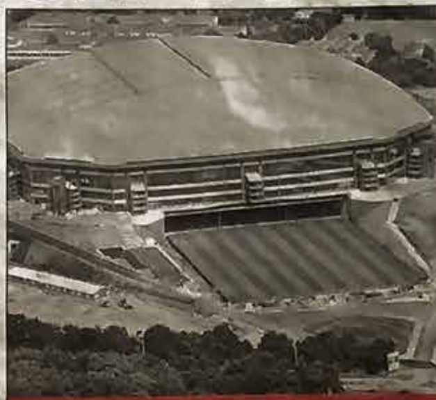
Arena AufSchalke ab 2001
